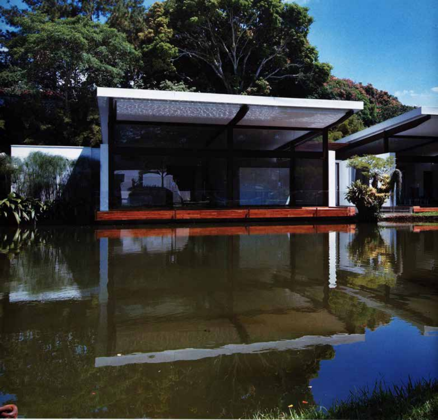
Arquitecto: FREDDY IVÁN CLAVIJO ■ Arquitecto colaborador: Jesús Mauricio López Quintero ■ Ubicación: Valle del Cauca ■ Fotografía: Federico Orozco.
