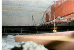
Foto-16 Intersección de la viga del eje A, con la viga del eje 7.
