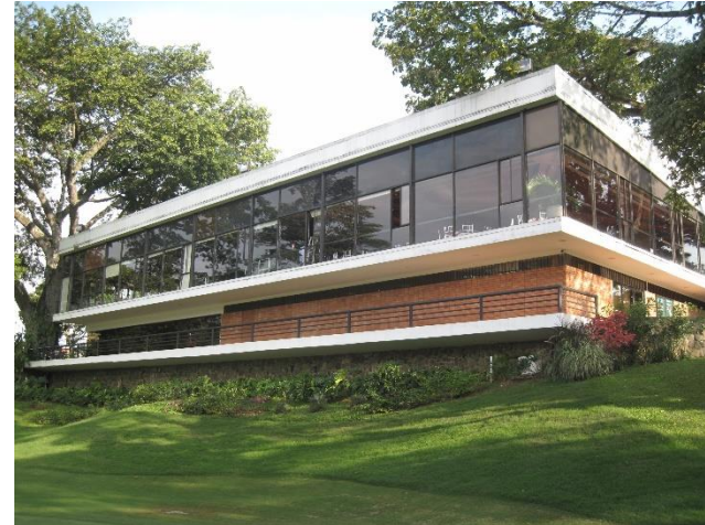
Borde voladizo Actual
