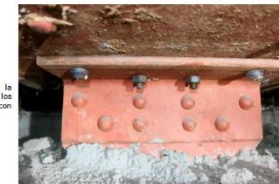
Foto-19 Conexión de la columna de los ejes 6-A0, con viga del eje 6
