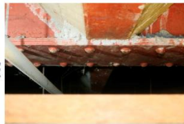
Tercio central de la viga del eje A0, entre ejes 5 y 4
