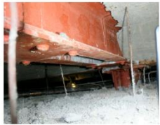
Tercio final de la viga del eje A0, entre ejes 6 y 5
