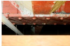
Foto-17 Intersección de la viga del eje A, con la viga del eje 7.
