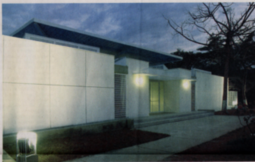
Con un área de 4.500 metros cuadrados, el 22 de marzo del 2007 se terminó la adecuación de las instalaciones del Liceo Francés Paul Valéry, luego de haberse iniciado las obras el 16 de mayo del 2005.
